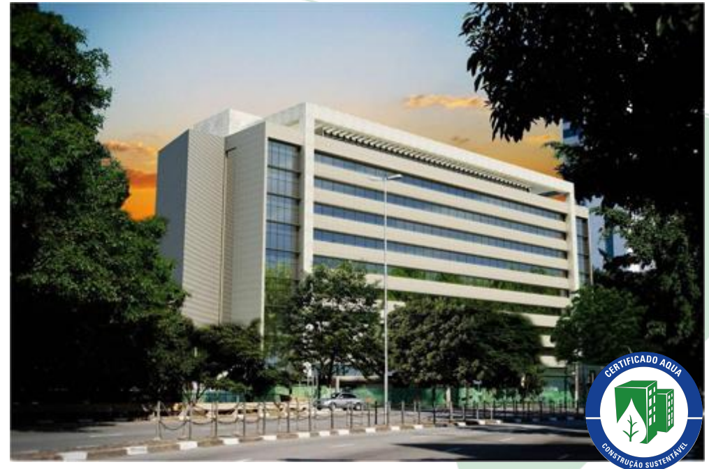
RETROFIT HOSPITAL EMÍLIO RIBAS
